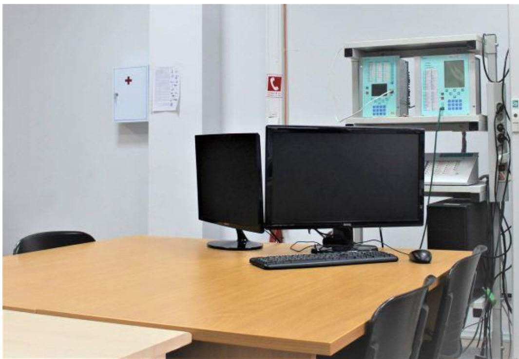
Рис. 12 Лабораторный комплекс устройств РЗА энергообъектов напряжением 6-35 кВ
