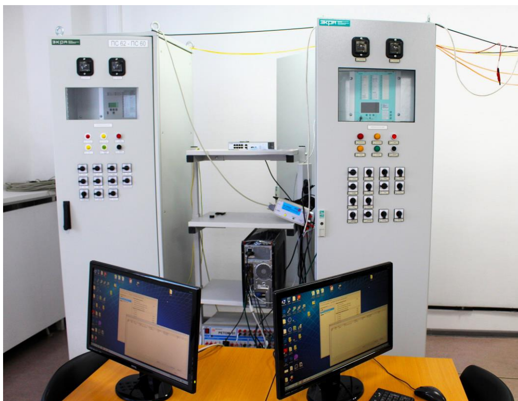
Рис. 6 Лабораторный комплекс на основе шкафа ШЭ2607 092
