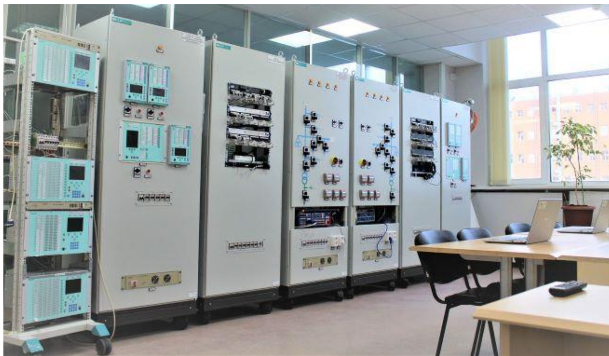
Рис. 16 Лабораторный комплекс «Высокоавтоматизированная подстанция»
